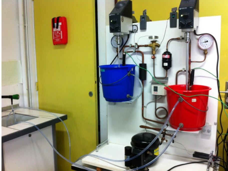
Figure 8 Pompe à chaleur avec dispositif de refroidissement
