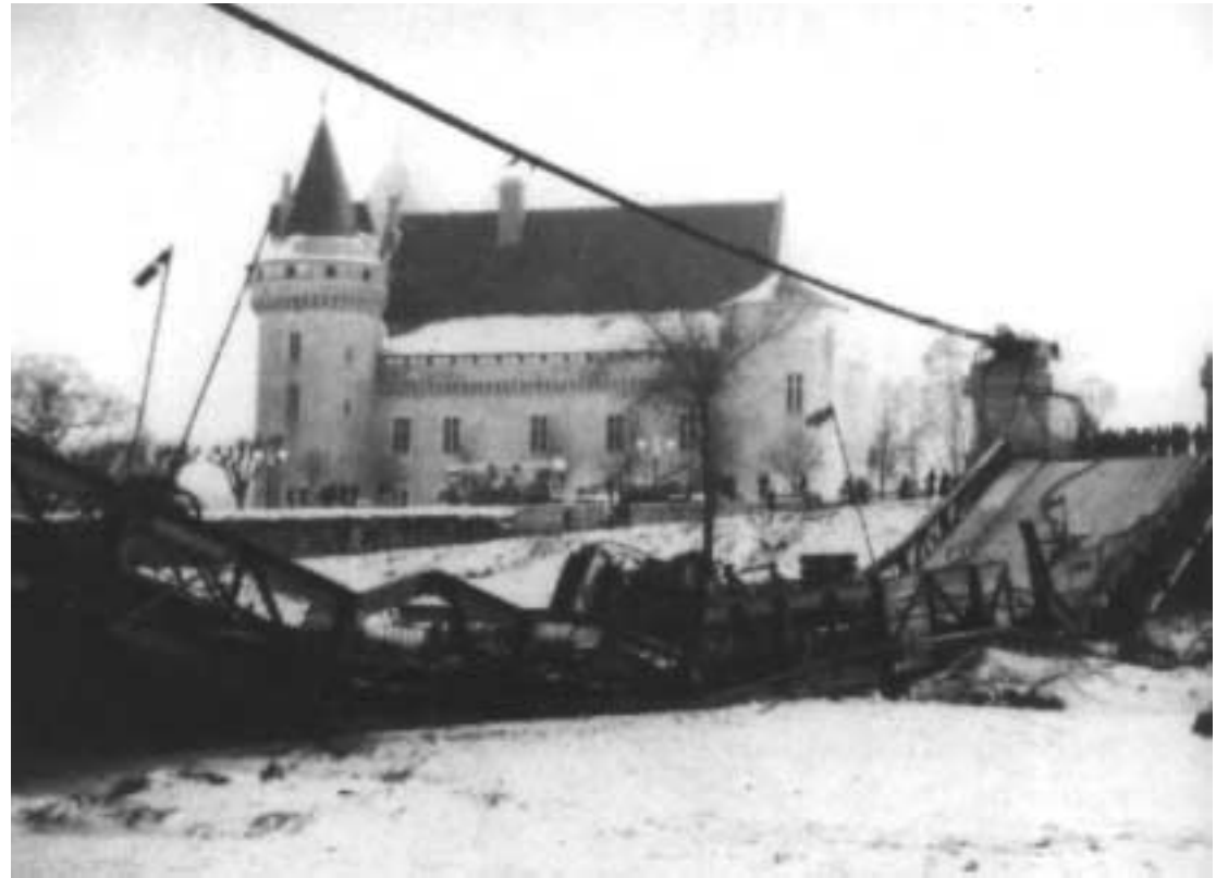
rupture d'un câble de soutien du pont de Sully-sur-Loire durant l'hiver 85, ayant entraîné la chute du pont
