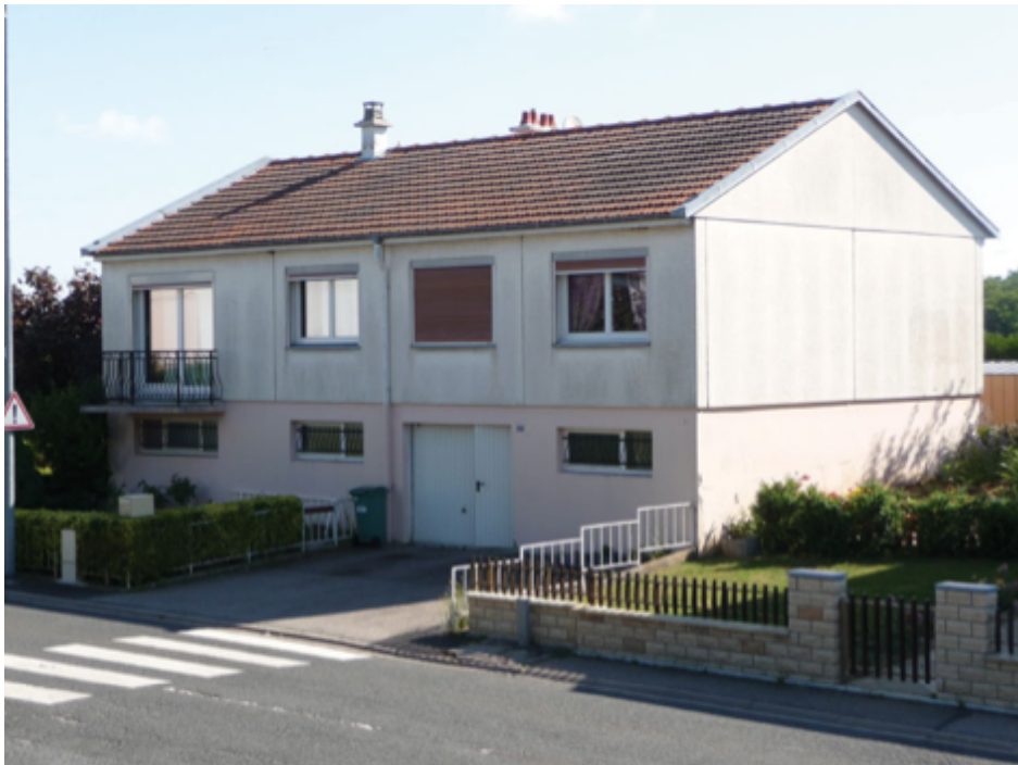
La maison de Jacques Tremon avant les travaux..
