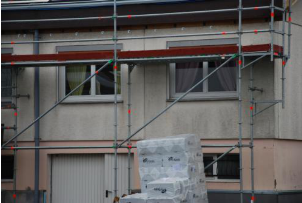
L'entrée de la maison en chantier ©JL
