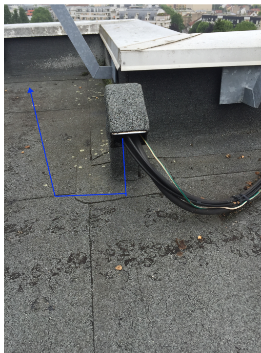
(b) passage des cables du toit au dernier étage
